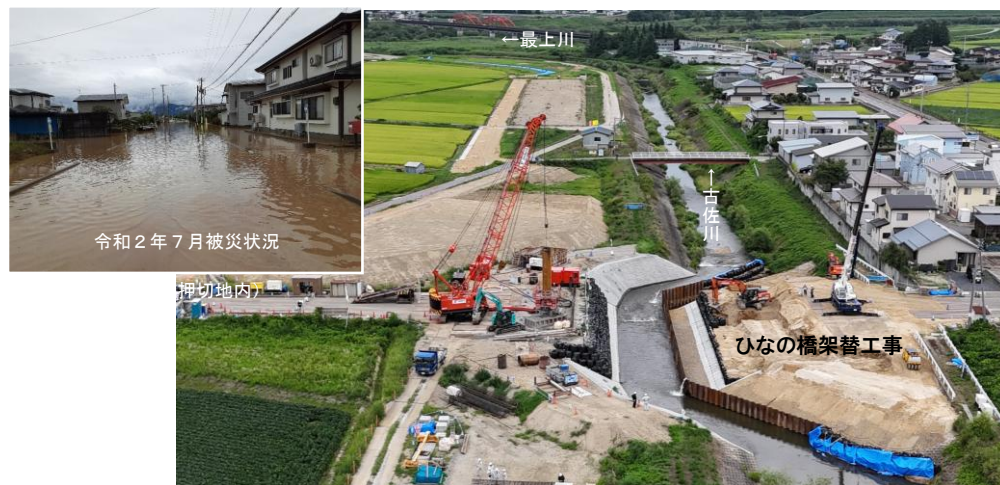
▲ 古佐川整備（河北町ひなの橋架替）状況（令和7年8月撮影）
