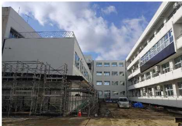
改築中の致道館高校
