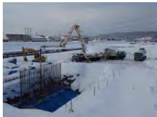
雪国における厳しい施工環境
