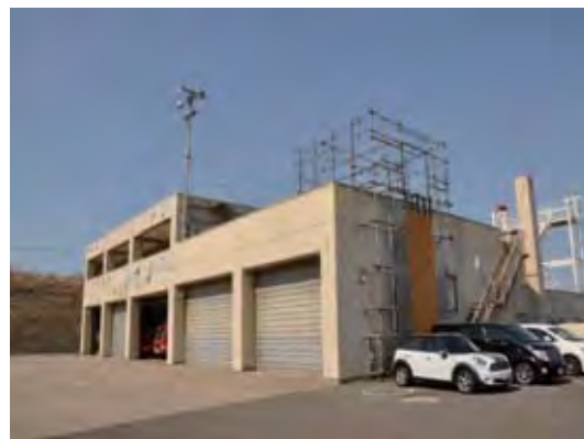
総合防災センターの整備を含め 再編整備を検討中の消防署（酒田市）
