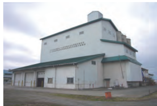
飼料用米専用のビンを設けたカントリーエレベーター
