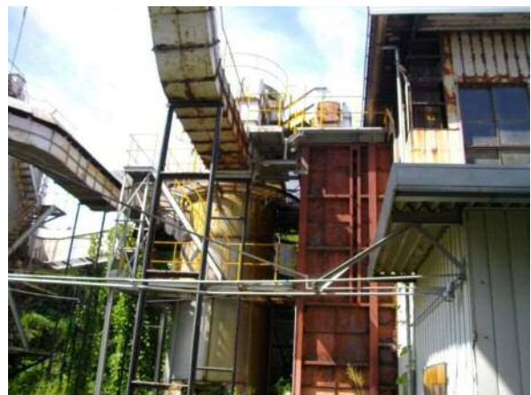
廃止後未解体となっている焼却施設（上市市）
