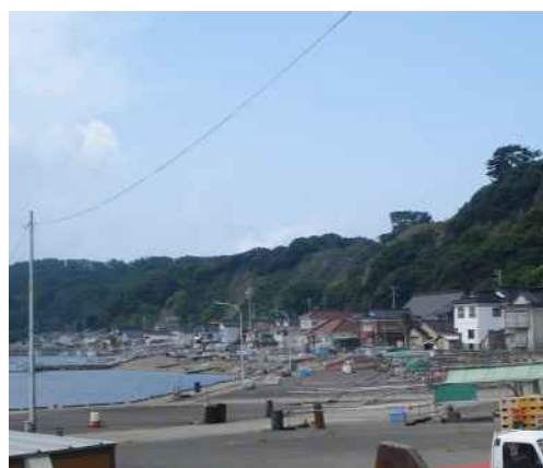
山形県沿岸の住宅地の状況
