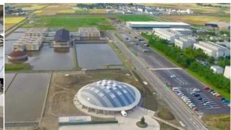
宿泊滞在施設：ショウナイホテル スイデンテラス(左奥) 子育て支援施設：キッズドーム ソライ(中央手前) (YAMAGATA DESIGN(株)提供)
