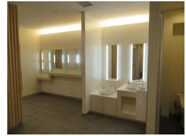
「道の駅米沢」有機EL照明 (平成30年度オープン)
