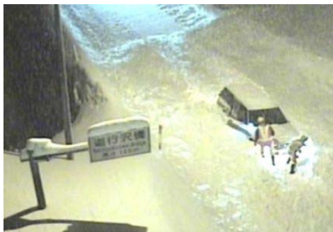
国道 112 号雪崩発生状況(西川町月山沢) 〔平成 27 年 2 月 11 日～15 日 全面通行止め〕
