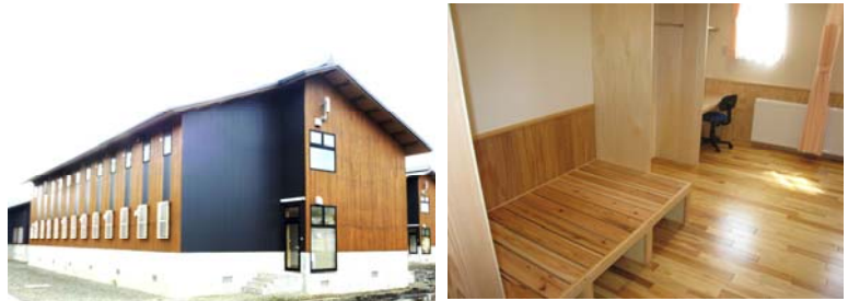
県立農業大学校学生寮（新庄市）
