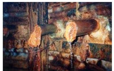
集水井の排水孔の閉塞による機能低下
