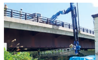
長寿命化のための橋梁点検
