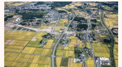
整備が進む国道113号梨郷道路と国道287号米沢長井道路
