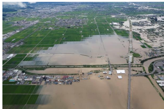
令和2年7月豪雨の浸水被害（村山市）
