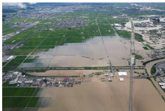
令和2年7月豪雨の浸水被害（村山市）
