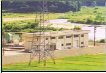
清水揚水機場 外観
