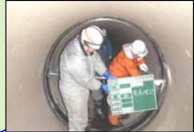
用水路内部(パイプライン)
