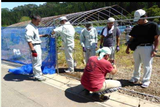
電気柵の共同設置
