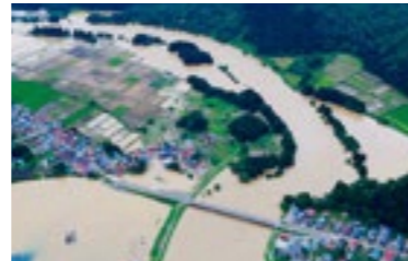
最上川の氾濫状況(大石田町豊田)
