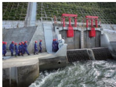
①頭首工の取水ゲート
