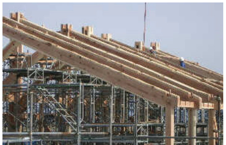
《普通教室棟の昇り梁》
