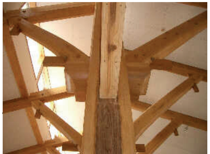
《柱と方杖》 教室棟の40cm角の柱の廻り
