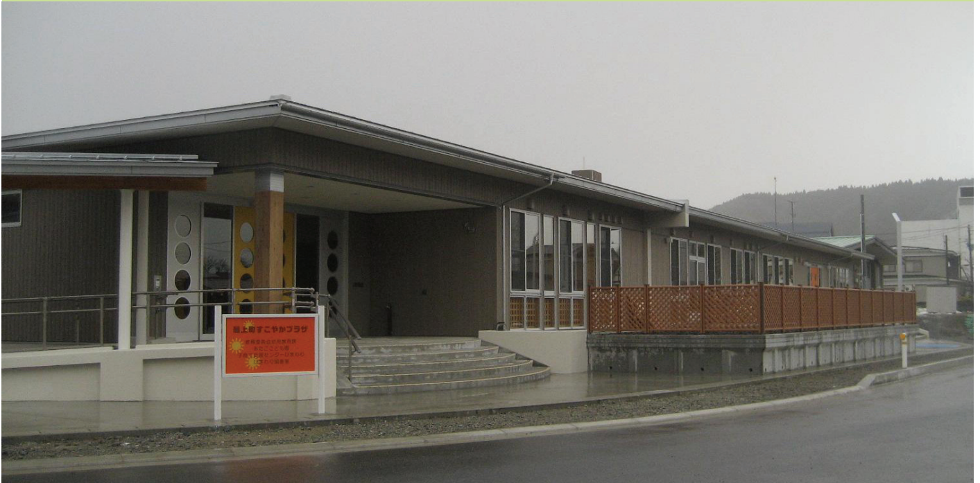
《外観写真》外壁の腰壁に木の羽目板張を施し、経年により徐々に建築物の風格が現れるよう計画した
