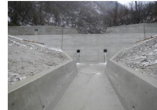
【治山:溪間工(治山ダム)】
