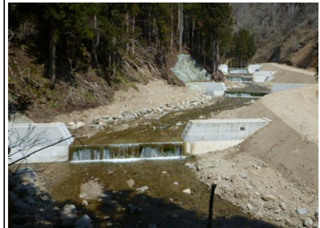
溪床の安定化を図る治山ダム
