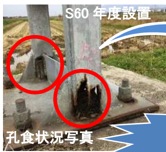
◎防雪柵の腐食状況写真（30年以上経過）
