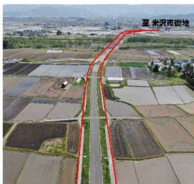
国道 287 号 (米沢長井道路)
