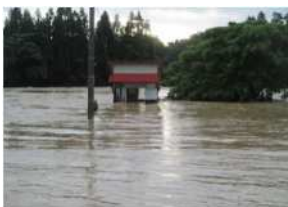
ポンプ場の浸水（村山市）
