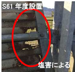
◎防雪柵の腐食状況写真（30年以上経過）
