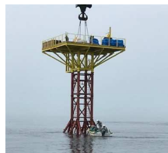
< ボーリング調査 >
