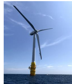
浮体式洋上風力発電機
