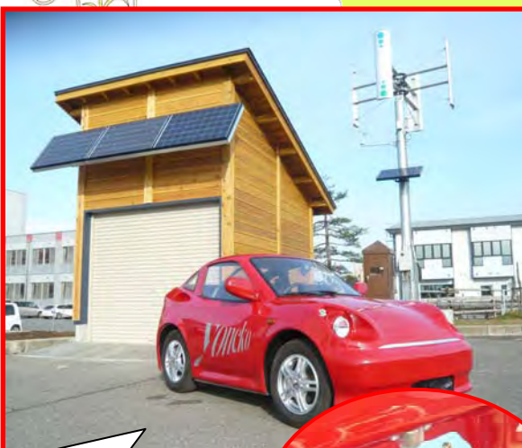
太陽光発電パネルを備えた「エコ車庫」と風力発電装置。公道を走行できるナンバーを取得しました。
