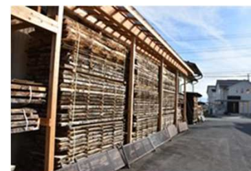
広葉樹材の保管施設整備支援
