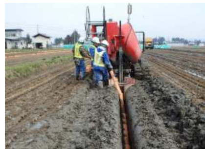
地下かんがいの施工(川西町)
