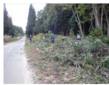
地域住民と連携した緩衝林帯の整備
