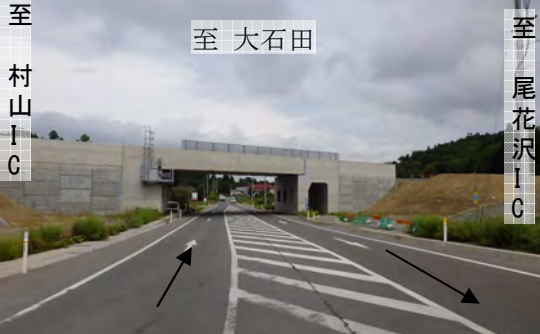
②現道状況(R2.9月撮影)村山→大石田方向
