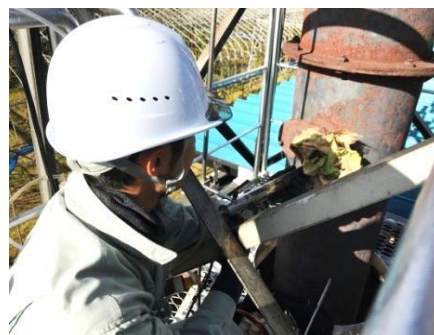
焼却炉での検査の様子
