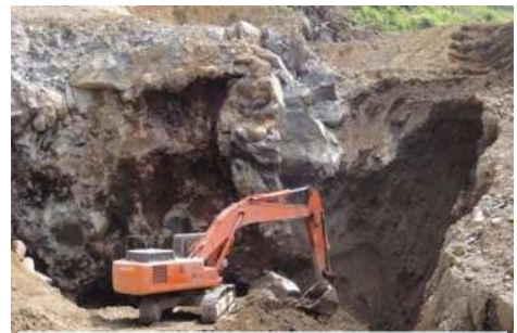
< 遊佐町の採石現場の状況 >
