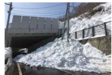
米沢飯豊線 雪崩発生状況 (H30.3：片側通行止め3週間)
