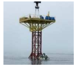
<ボーリング調査>
