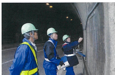
トンネル点検作業
