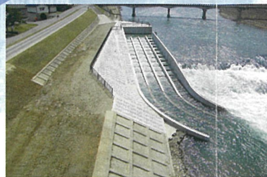
生態環境を守る河川工事
