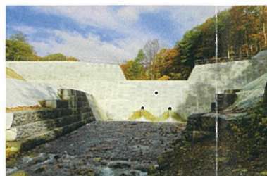
土砂災害を防ぐ砂防ダム
