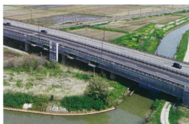
橋の補修作業
