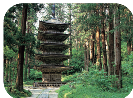
羽黒山 五重塔(鶴岡市)
