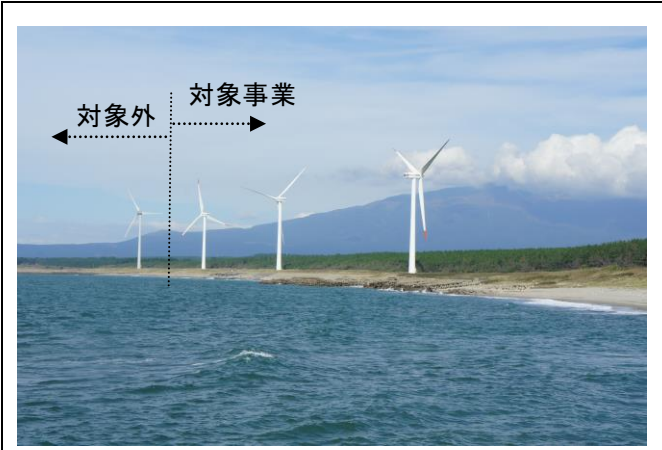
写真 6. 既設風力発電機（宮海海水浴場側）をのぞむ
