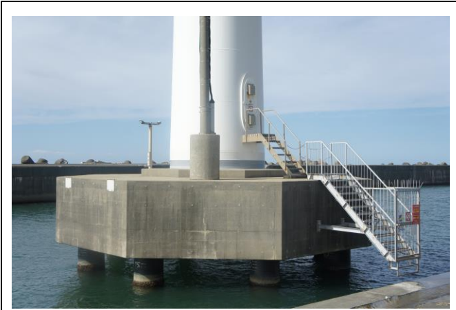
写真 4. 既設風力発電機の基礎部をのぞむ
