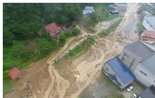
大雨による被災状況
