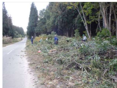
地域住民と連携した緩衝林帯の整備
