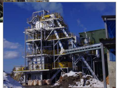
バイオマス発電施設
