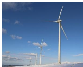
県営風力発電所
