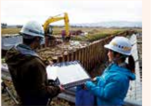
業者との現場確認
