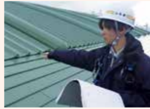
屋根改修工事の現場確認
