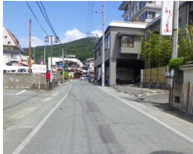
【Aから見た現場の状況】
