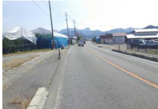
【Aから見た現場の状況】
