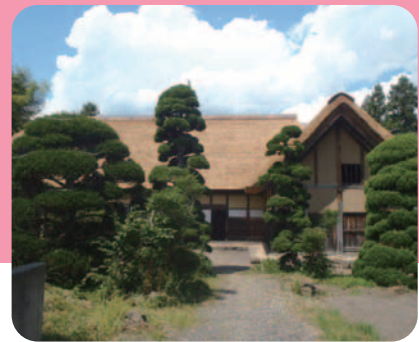
▲(株)たくみの手掛けた国指定文化財 旧尾形家住宅建造物保存修理工事
