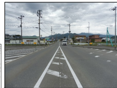
▲未改修区間（ボトルネック箇所）
