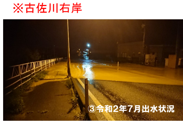
③(主)寒河江村山線冠水(7/28)
