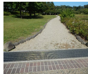
砂利舗装のため、車椅子走行が困難
