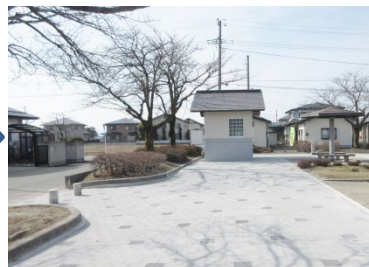
バリア解消(段差を解消し舗装)
