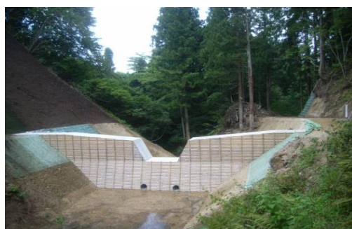
えん堤の残置型枠
