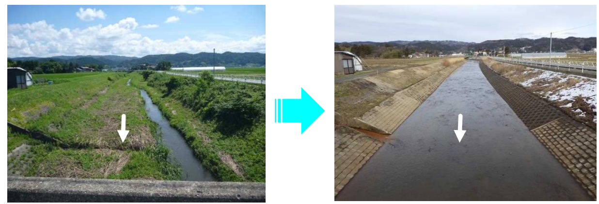
▲ 新井田川(酒田市) 令和元年度実施 堆積土砂撤去
