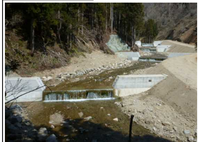
溪床の安定化を図る治山ダム
