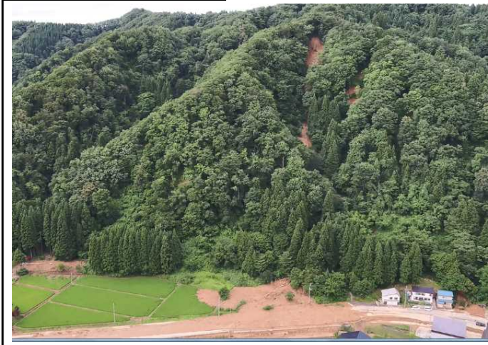
河川上流部の山地で発生した山腹崩壊
