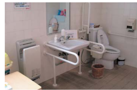
車いす利用の方や高齢者なども利用しやすい、多目的トイレが設置されています。
