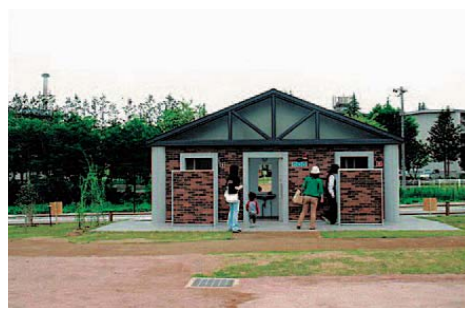
公園内に設置された多目的トイレには、入口の段差はなく、子ども連れや障がいのある方などもみんなで使えるよう配慮されています。
