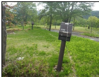
弓張平公園 キャンプ場電源設備更新
