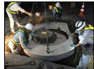
写真 管路施設の耐震化 (マンホール浮き上がり防止)
