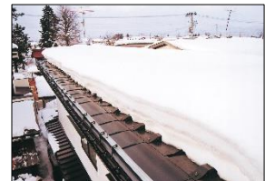
【克雪化の例】 屋根に融雪設備を設置
