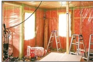
【寒さ対策・断熱化の例】 外壁に断熱材を設置
