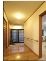
【バリアフリー化の例】 廊下に手すり設置
