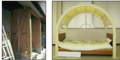
【減災・部分補強の例】 壁に構造用合板を設置、防災ベッドの設置
