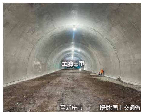
国道47号 高屋道路
