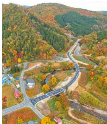
(主) 大江西川線 貫見工区
