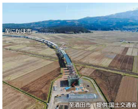
国道7号 遊佐象潟道路
