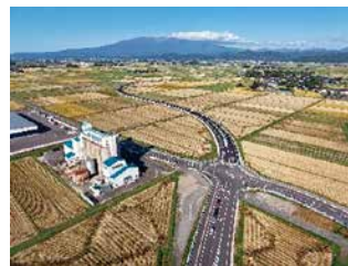
整備後(真室川方面を望む)
