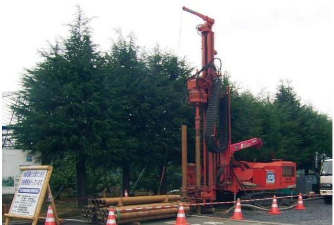
[ソニックドリルによる井戸掘削]
