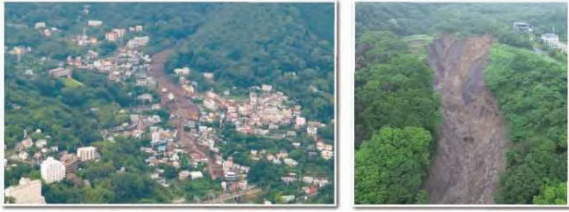
R3.7月 静岡県熱海市 死者28名、住宅被害98棟
