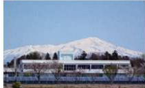
山形県工業技術センター庄内試験場
